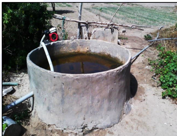
Photo 3 : Bassin avec motopompe à Mbadal Yandi (Malika)
