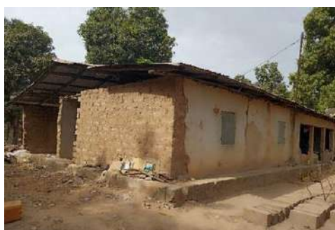
Photo 7 : Mur détruit en reconstruction
