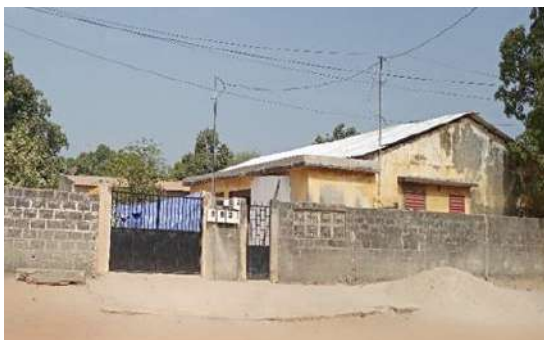
Photo 3 : Maison en dur avec toiture en tôle
