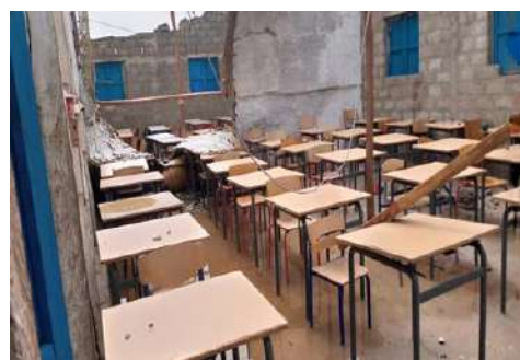
Photo 8 : Salle de classe à la toiture ouverte
