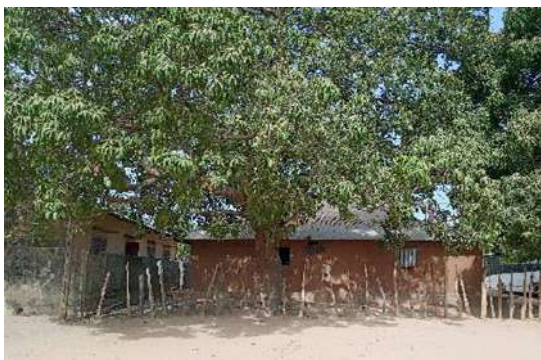
Photo 1 : Maison en banco avec une toiture en tôle
